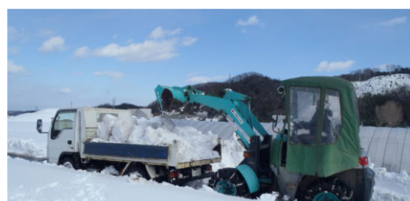
現場周辺の除雪
