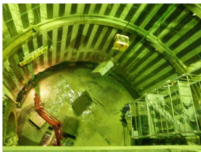
カッター切断による立坑 底盤コンクリートの撤去
