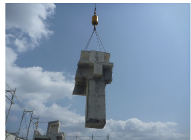
柱ブロックの吊り下ろし
