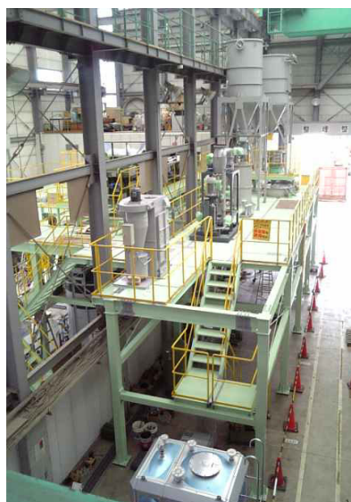
破碎・ふるい工程
