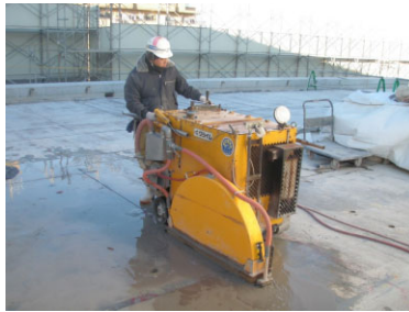
フラットソーによるスラブ・梁切断
