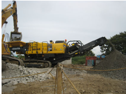
コンクリートガラの砕石化
