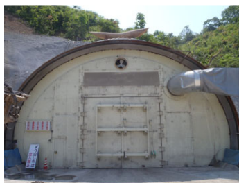
坑口の防音扉
