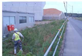
現場周辺の草刈り
