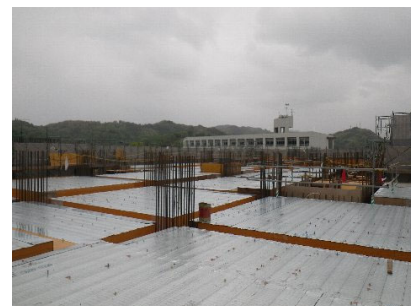
フラットデッキ型枠の施工状況
