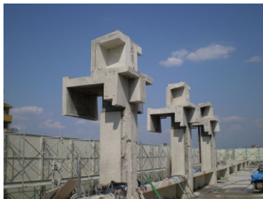
スラブ・梁・壁切断撤去後
