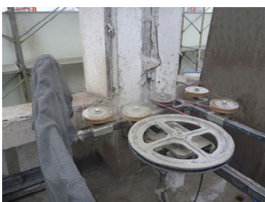
ワイヤーソーによる柱の切断
