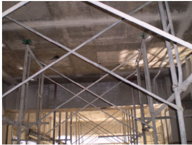
スラブ切断用支保工組立
