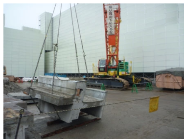
切断部材の吊り下ろし
