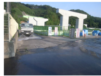
散水車による路面洗浄
