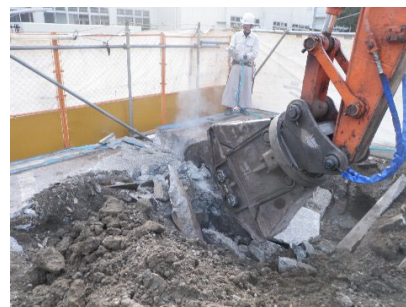
圧砕機による防音ハウス 基礎コンクリートの解体
