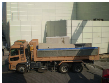
切断したブロックの積み込み
