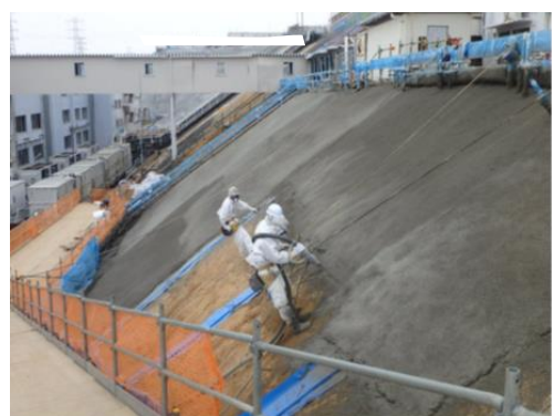
モルタル吹き付け
