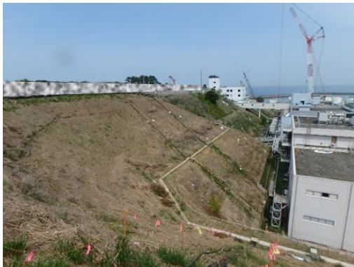
法面フェーシング
