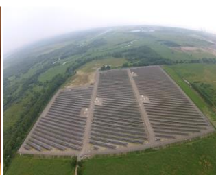
苫小牧勇払メガソーラ全景
