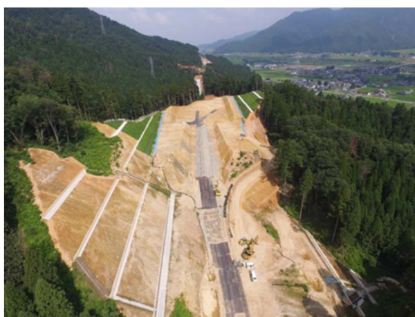
UAV(ドローン)による空撮 現場全景
