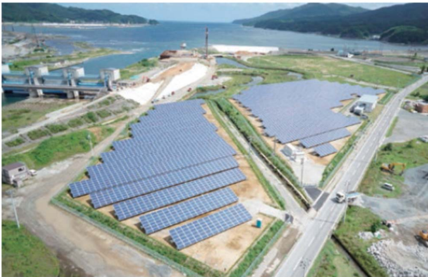
津軽石発電所（宮古発電合同会社）
