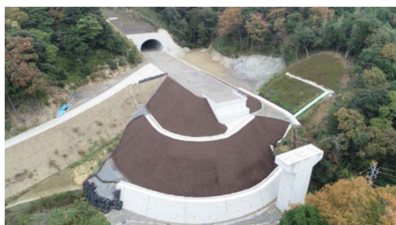
トンネル坑口部と堤体
