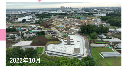
2022年10月 構造物の建設
