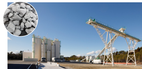
人工砕石製造プラント (左上は石炭灰リサイクル砕石)
