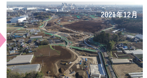
2021年12月 土地の造成・改良工事
