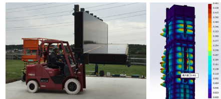
フォークリフトで運べるシステム型枠(左)、側圧検討機(右)
