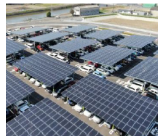
再エネ改修・駐車場屋根
