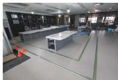
⑥ ボーダーパネル設置により固定床と同レベルにビルトインし、仕上げ。
