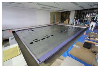
④ 配線穴付めっき鋼板敷設
