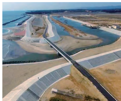
河川堤防工事
