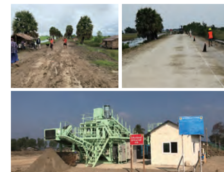
東南アジアでの施工の様子
