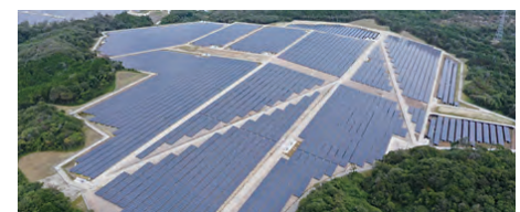
太陽光発電所
