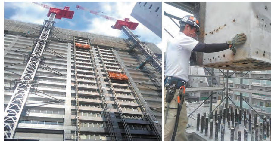
PCa工法で作業の効率化、省力化により工期短縮を実現
