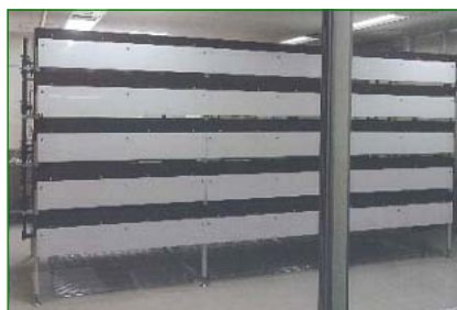
栽培プラントの設置状況
