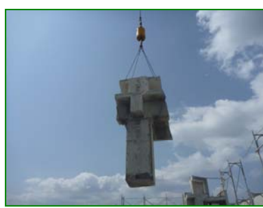
柱ブロックの吊り下ろし
