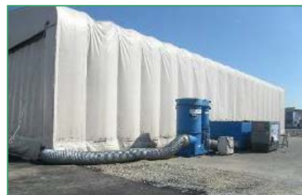
大型テントの設置
