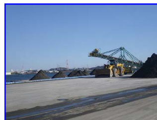
処理土搬出状況
