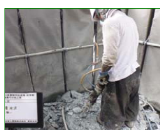
杭頭処理時のノイズソーバーによる養生
