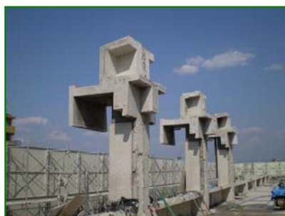
スラブ・梁の撤去後
