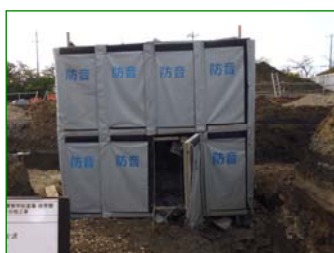
杭頭処理時のノイズソーバーによる養生
