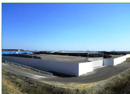
仮置場での保管状況
