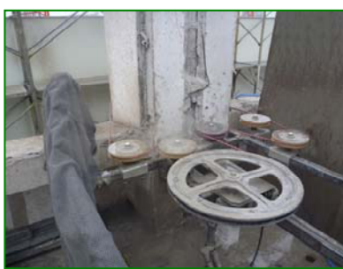
ワイヤーソーによる柱切断
