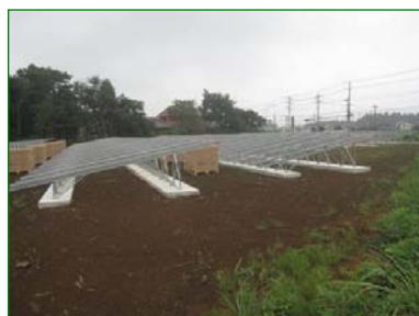
パネル基礎・架台
