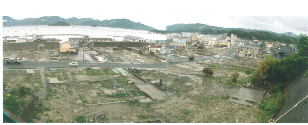
北浜町地区撤去後
