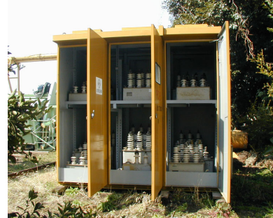
高圧コンデンサの保管状況
