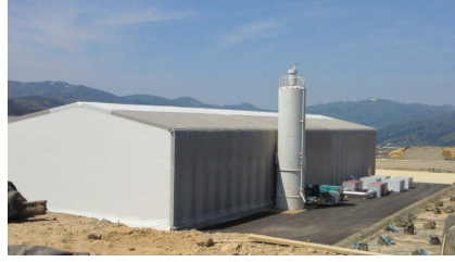
汚染土壌浄化プラントの設置状況
