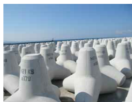
シェルコンクリートを使用した消波ブロック
