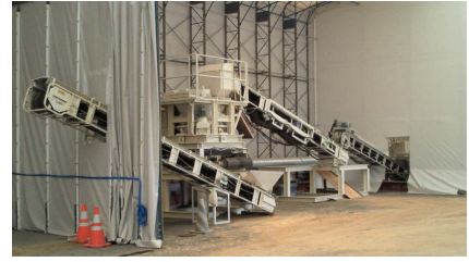
ツイスタープラントの設置状況
