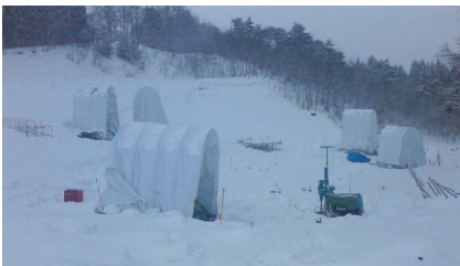
雪の中の調査状況
