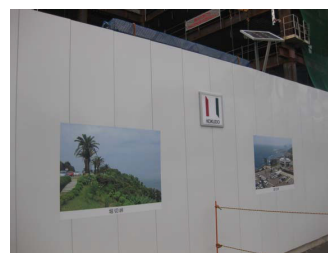
ソーラーパネルの設置
