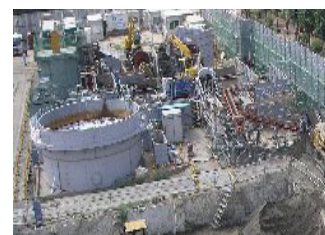
浄化プラントの設置状況
