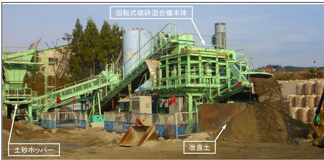
回転式破碎混合のプラント設置状況
