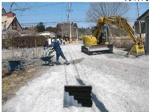
2012年2月市道の覆土施工
