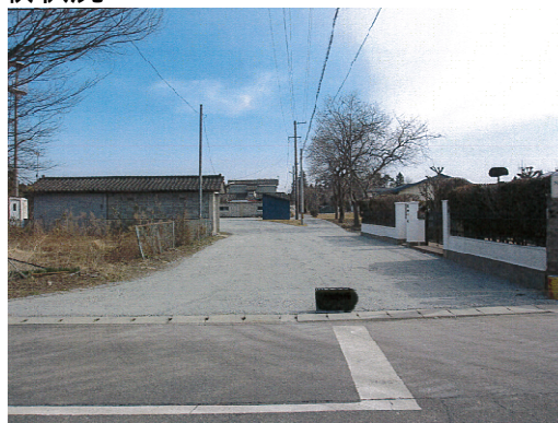
2012年2月市道の覆土施工完了
