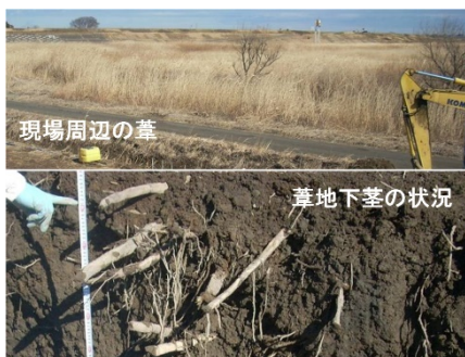
リサイクル前(地下茎混じり高含水比粘性土)
