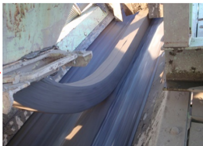
高含水比粘性土供給状況
