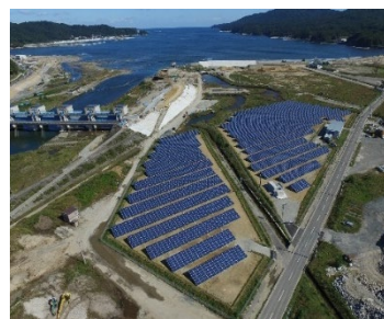
津軽石太陽光発電所 発電能力1,607kw パネル6,300枚
