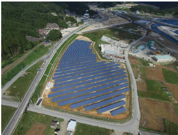
田老太陽光発電所 発電出力 2,367kw、パネル 9,282枚
