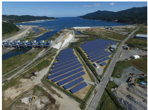
津軽石太陽光発電所 発電出力 1,607kw、パネル 6,300枚
