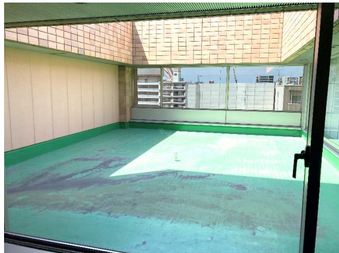
△⑤: 北側テラス(共用スペース化予定)
