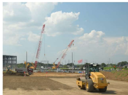
自動化施工用振動ローラによる 締固め状況
