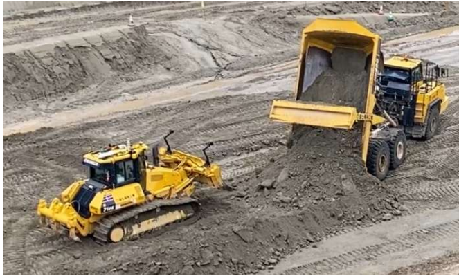
自動ブルドーザと有人ダンプトラックによる 連携管制状況
