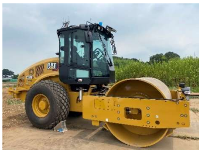
自動化施工用に艦装した 振動ローラ
