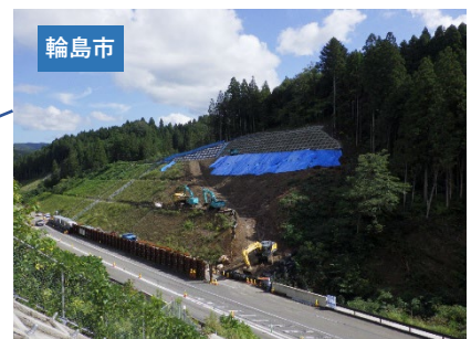
輪島市 R6 能越道輪島道路法面復旧工事
